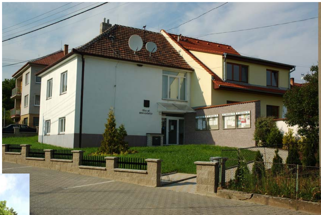
Oprava boční zdi pro umístění informačních tabulí
