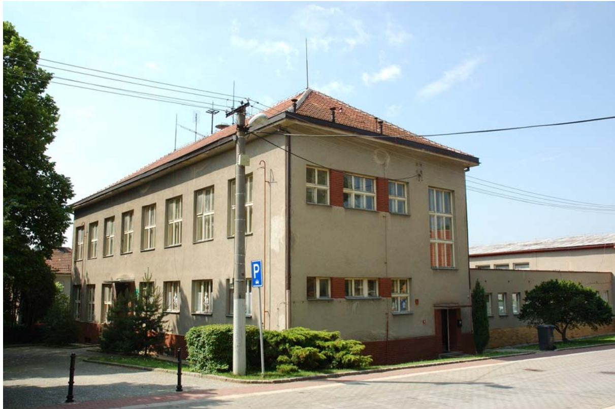
Budova bývalé ZŠ, která nyní slouží jako mateřská škola a pobočka knihovny Jiřího Mahena.
