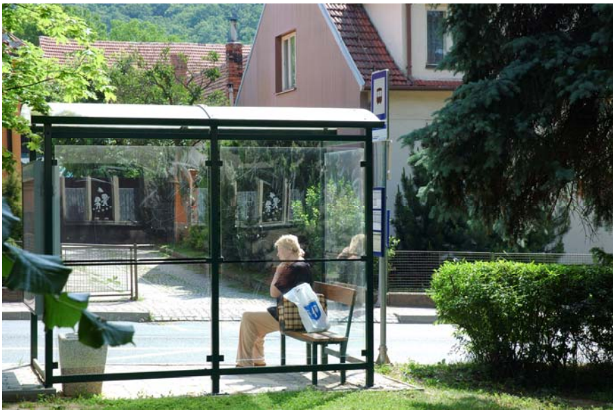
Přístřešek na zastávce ve středu obce. Boční stěna je upravena jako „Úřední tabule“.
