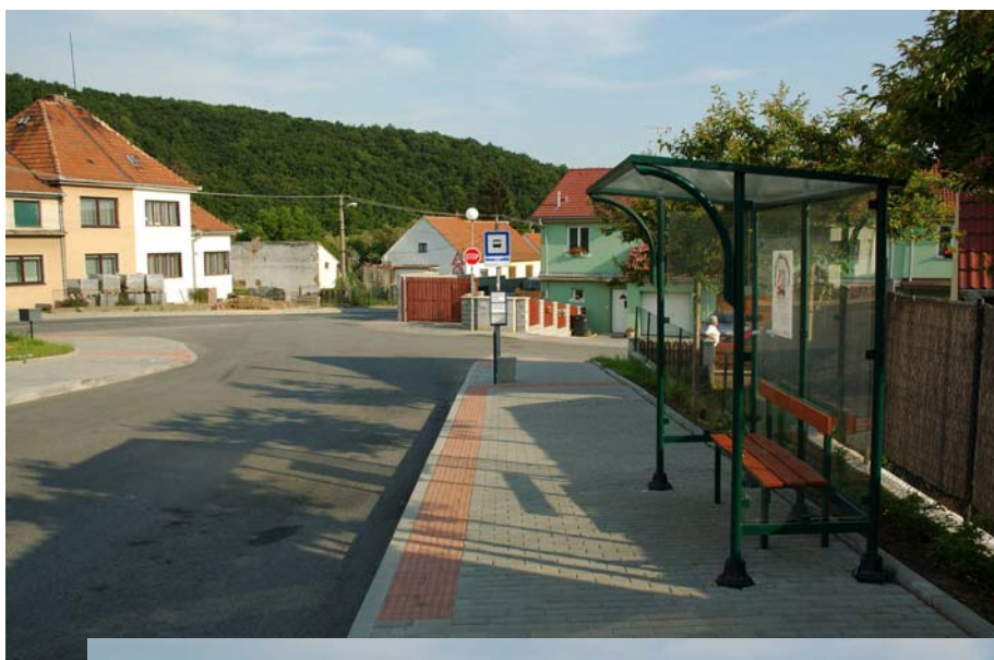
Autobusová zastávka s přístřeškem v horní části obce
