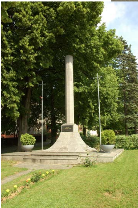
Oprava pomníku padlých z 2. světové války po narušení vodou a mrazem.
