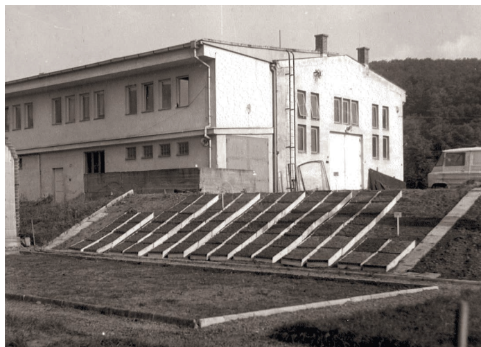
Budova A, zadní trakt, v popředí travní vzorkovnice na umělém svahu.
